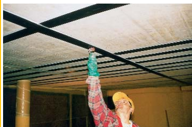
Wzmocnienie żelbetowej płyty stropowej taśmami węglowymi Sika® CarboDur®
