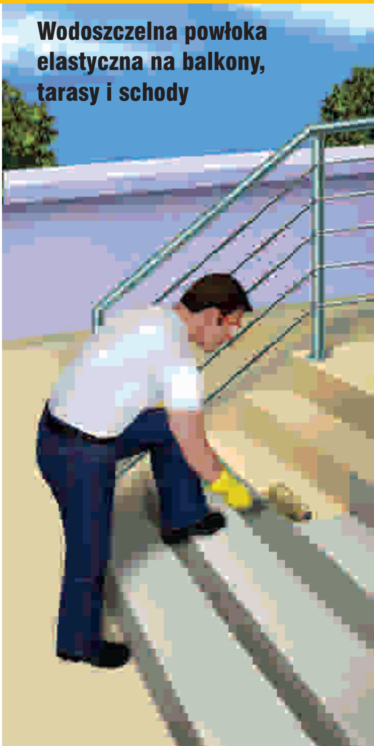
Sikafloor®-400 N Elastic + stanowi wodoszczelną warstwę
